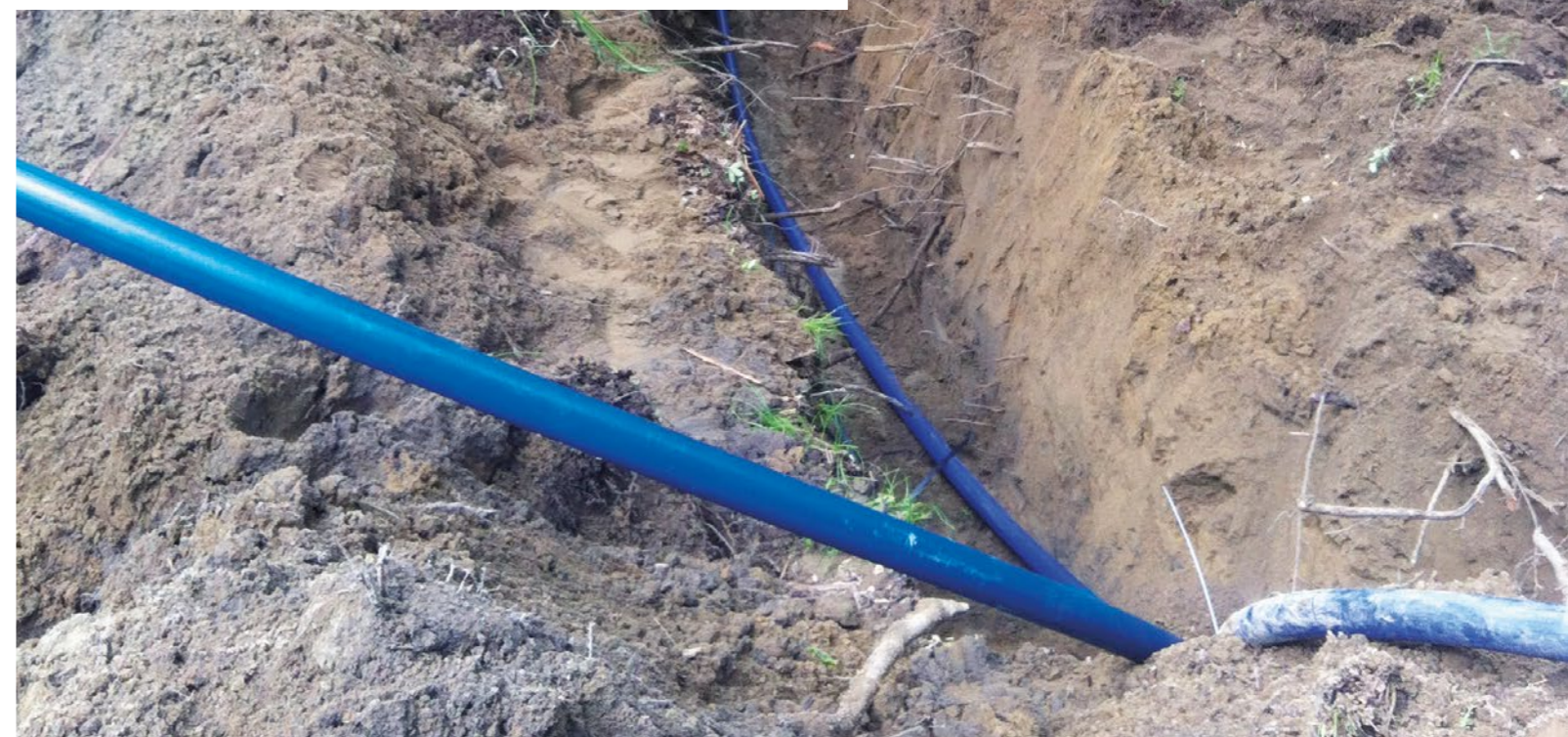
La posa dei cavi in fibra ottica nel cantiere San Piero - Stella Maris (Direzione Infrastrutture Digitali di UniPI - DID)
