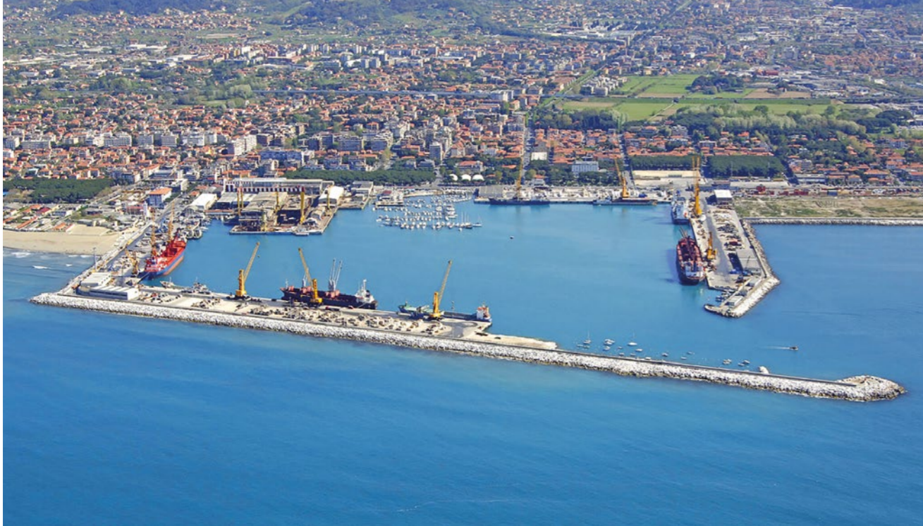
L'importante nodo infrastrutturale del porto di Marina di Carrara
